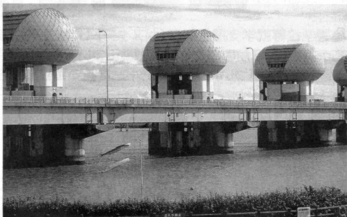
雨による出水でゲートを全開中の長良川河口堰。三重県桑名市で
